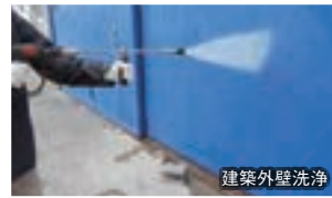
建築外壁洗浄
