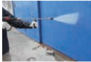
建築外壁洗浄
