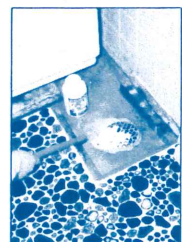
浴室の排水管の洗淨
